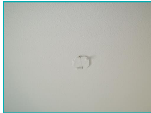
Ceiling Fan Prep
